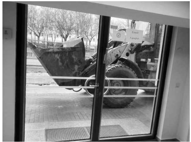
Baufahrzeug passiert Eingang Haus A
