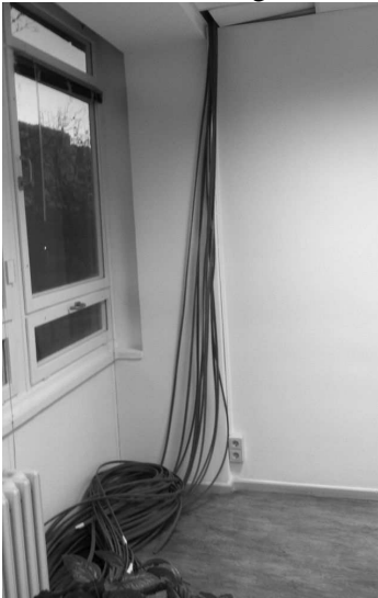
Kabelarbeiten zur Vernetzung
